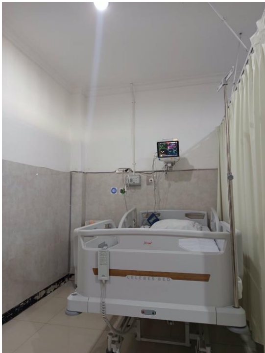
Tempat tidur elektrik dengan pengaman sisi, rem, bedside monitor, outlet gas medis, dan tirai pemisah
